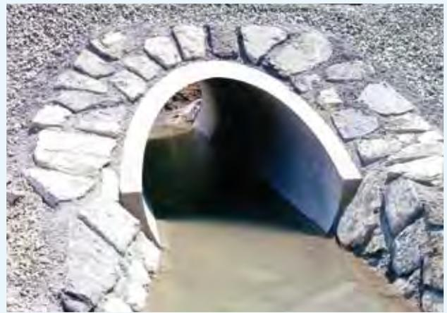
*Die Wasserdurchlässe werden mit grosser Sorgfalt in die bestehenden Böschungen sowie in den Wasserhaushalt der Fliessgewässer eingepasst. Foto: KBA*
