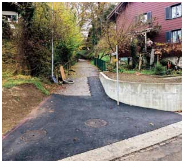
Die Hohlagass wird umfassend saniert
