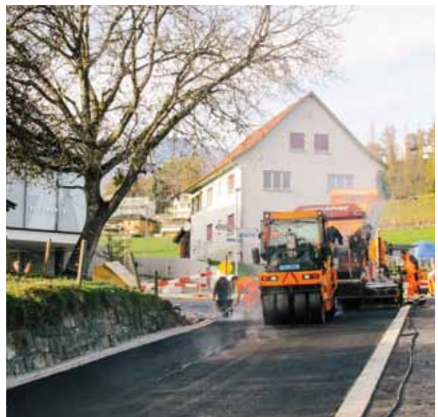
Teerungsarbeiten an der Bongerten Strasse
