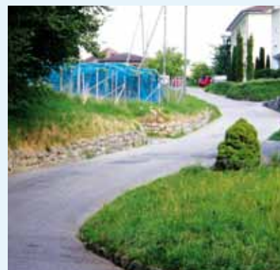
Müssnen: Die Landstrasse wird saniert
