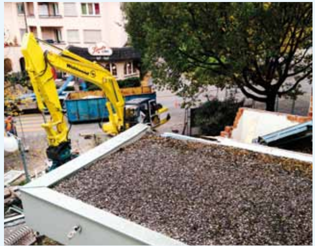
Die Abbrucharbeiten dauerten nur wenige Tage
