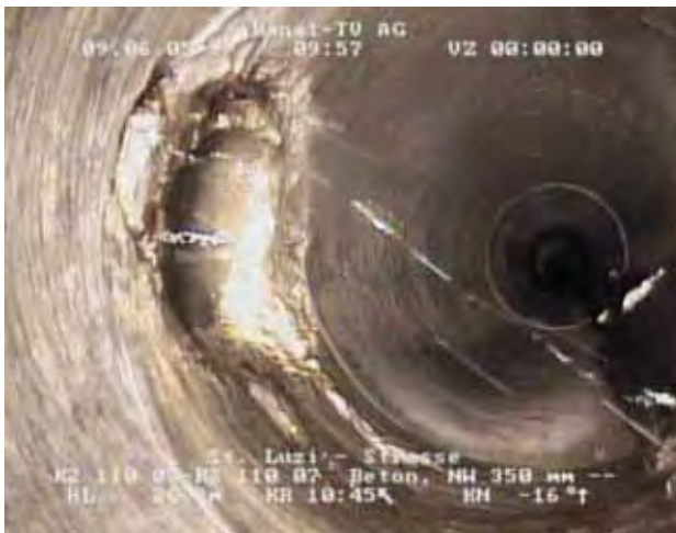
Aufnahmen von schadhafte Stellen in der Kanalisation: Grundwassereintritt, Wurzeleinwuchs, Risse und versetzte Rohrverbindungen
