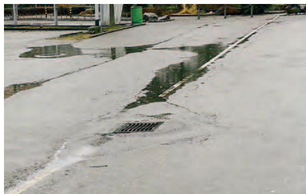
Das Regenwasser sammelt sich neben den Einlaufschächten
