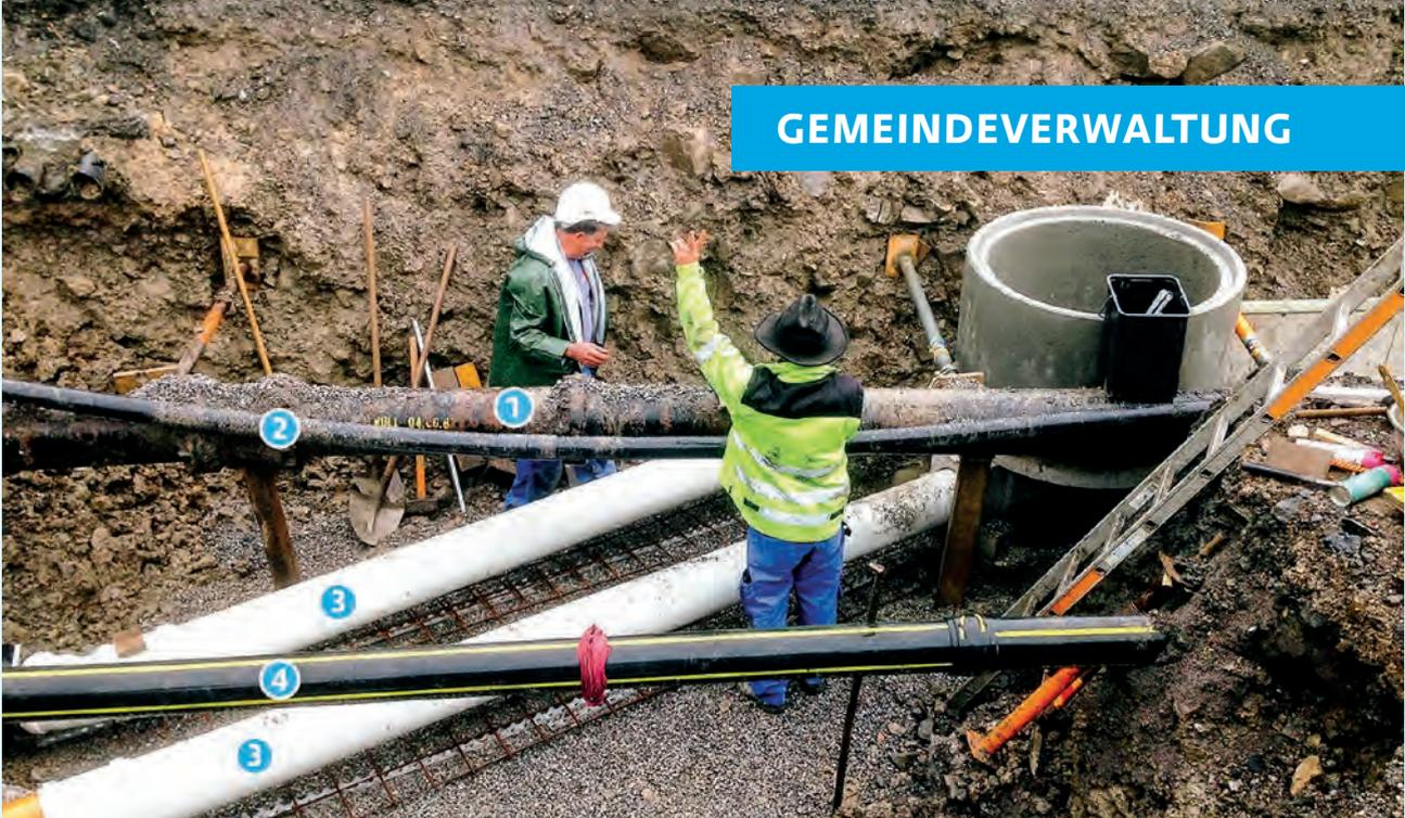
Werkleitungsbau mit Wasser-Transportleitung ①, Strom-Hochspannung ②, Kanalisation ③ und Gasleitung ④
