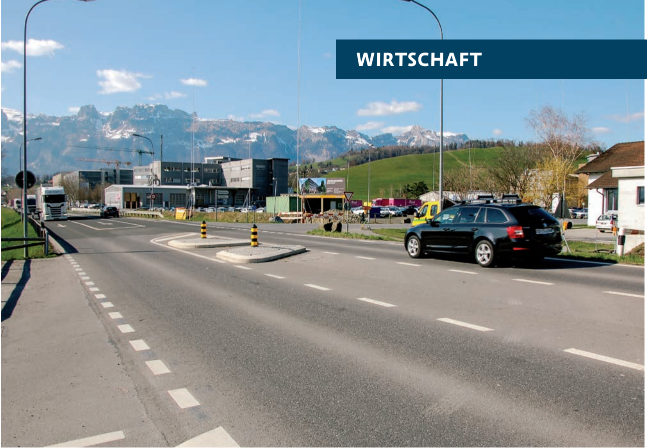
Die zentrale Ein- und Ausfahrt des Wirtschaftsparks soll als sogenannter T-Knoten mit einer separaten Abbiegespur und einer Ampelanlage im Jahr 2020 realisiert werden
