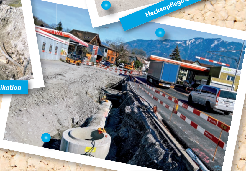
Eschnerstrasse mit Kanalisationsbau
