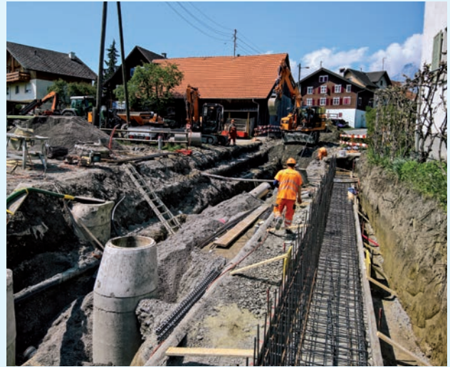
Die Bauarbeiten sind in vollem Gange
