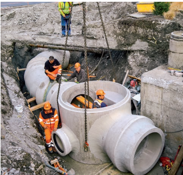
Vereinigungsschacht Mischwasser vor dem Hochwasserentlastungsschacht im Einlenker Aeulestrasse
