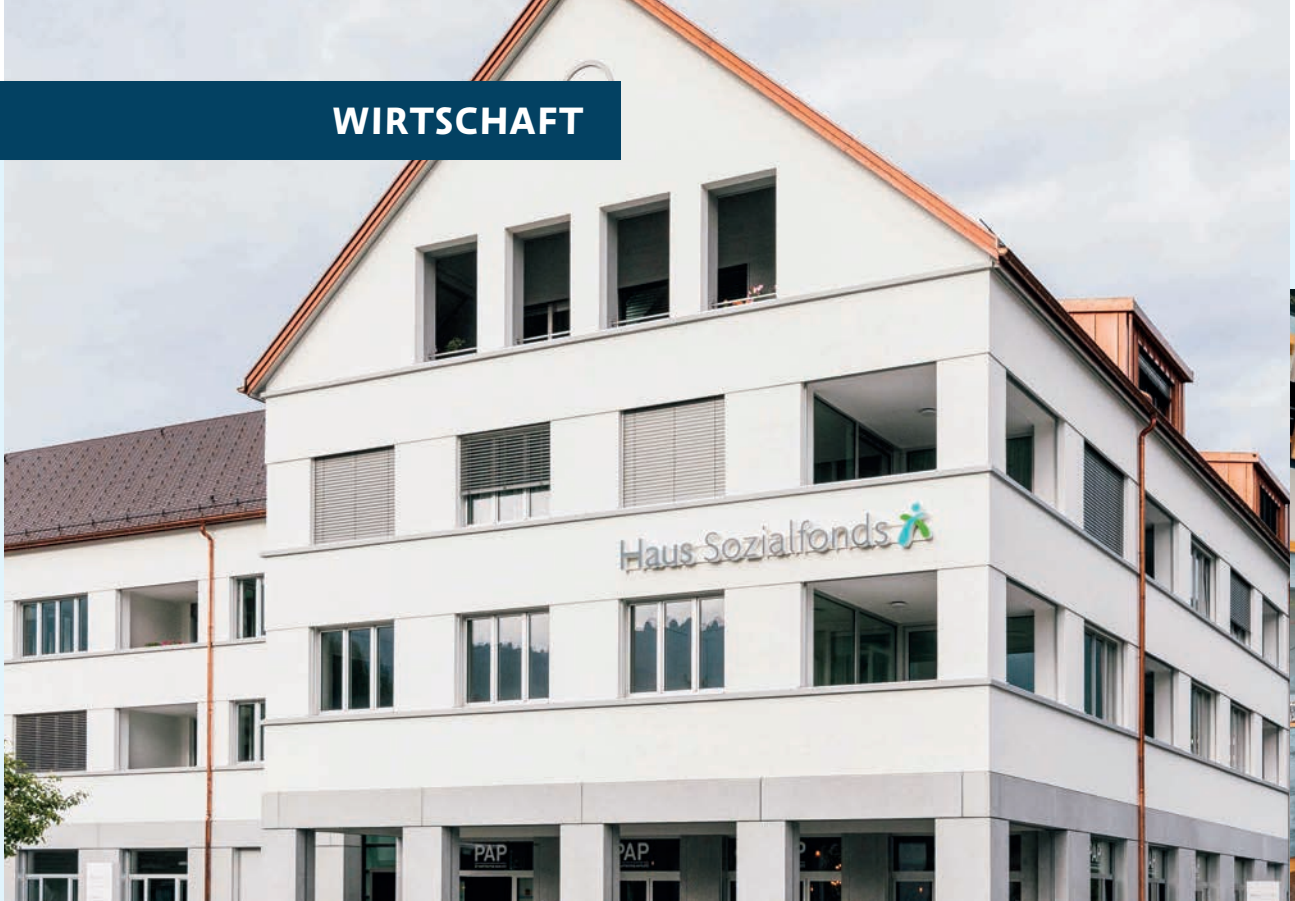
Mit der Fertigstellung des «Haus Sozialfonds Kreuz» ist die Dorfplatzgestaltung nun abgeschlossen
