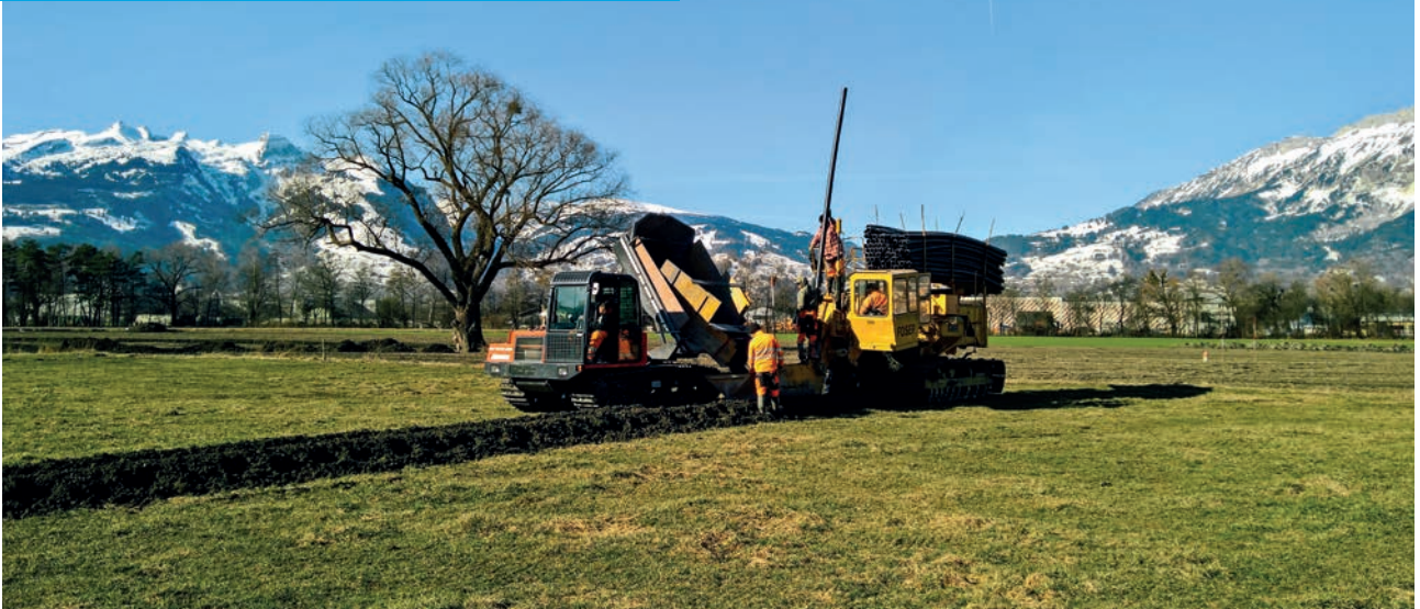
Grabenfräse im Einsatz
