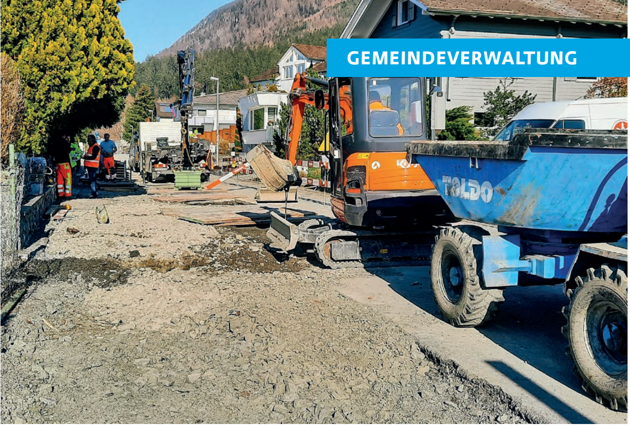
Schulstrasse Nendeln, Erstellung der neuen Trinkwasserleitung
