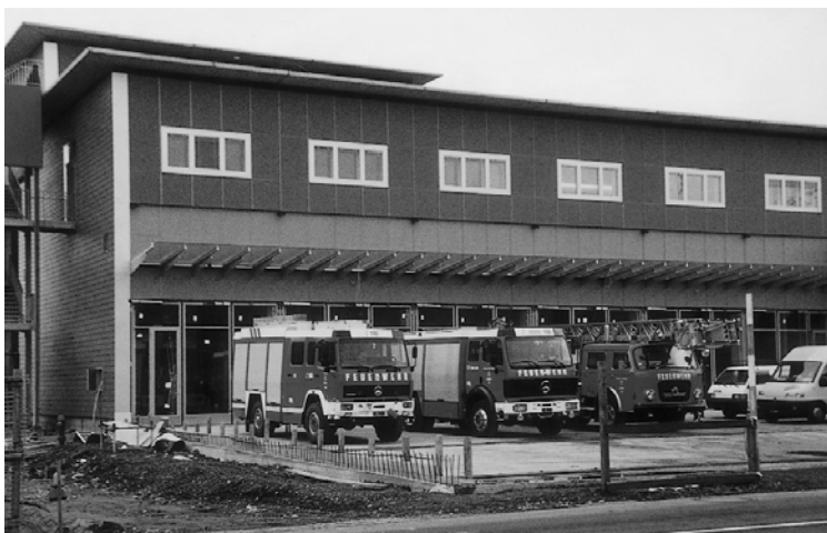
Hier sehen wir den Stützpunkt der Eschner Feuerwehr mit drei Tanklöschfahrzeugen.
