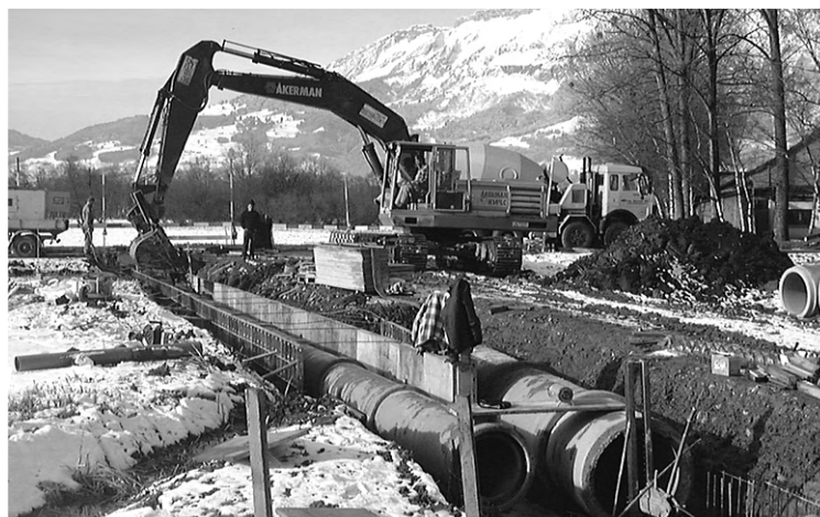
Kanalisation Erlenbritschen: Anschlussleitungen bei der Brühlgasse (Bauphase vom 6.12.1999)
