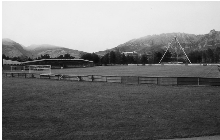
Hier sehen wir das Hauptspielfeld im Sportpark. Nach 25 Jahren soll die Anlage saniert und erweitert werden.
