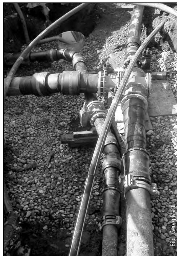
Im Jahre 2005 wurden die Wasserleitungen im Bereich des Presta-Kreisels in Eschen erneuert. Im Bild der Kreuzungspunkt der Wasserleitungen der oberen und unteren Druckzone.
