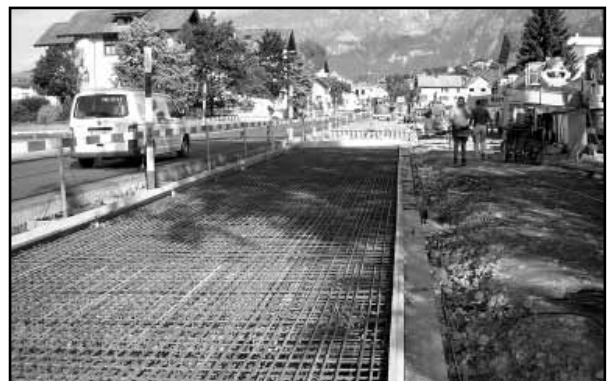
Bewehrung Fahrbahnplatte
