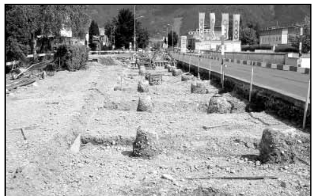
Pfahlgründung Fahrbahnplatte
