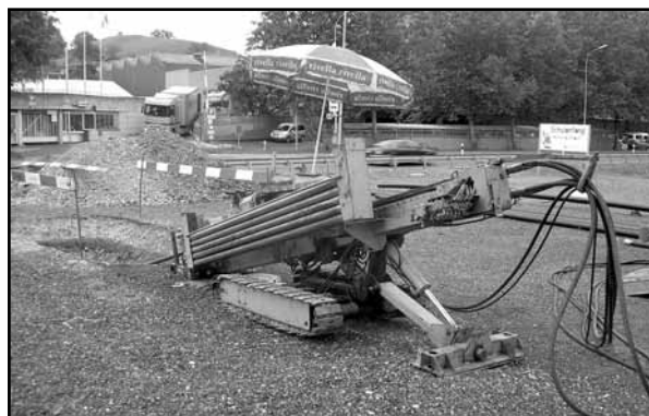
Horizontalbohrverfahren für Wasserleitung
