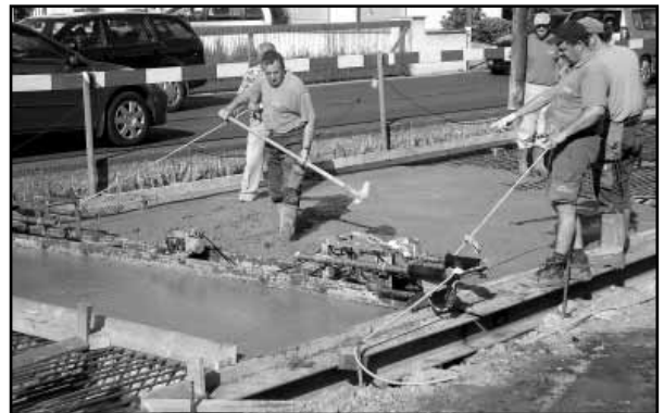
Betonarbeiten Fahrbahnplatte
