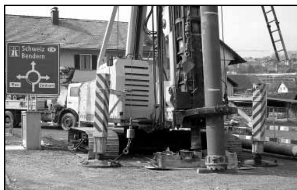
Bohrgerät für Voll-Verdrängungs-Bohrpfähle
