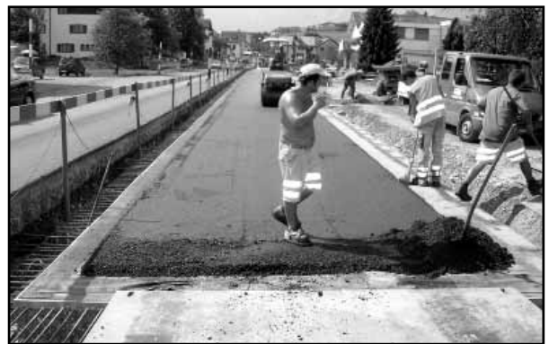
Belagsarbeiten Fahrbahnplatte
