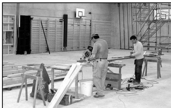
Innenausbauarbeiten in den Turnhallen.
