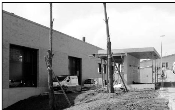
Umgebungs- und Bepflanzungsarbeiten an der Alemannenstrasse.
