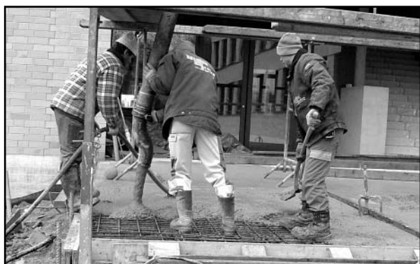
Letzte Betonarbeiten beim Haupteingang.
