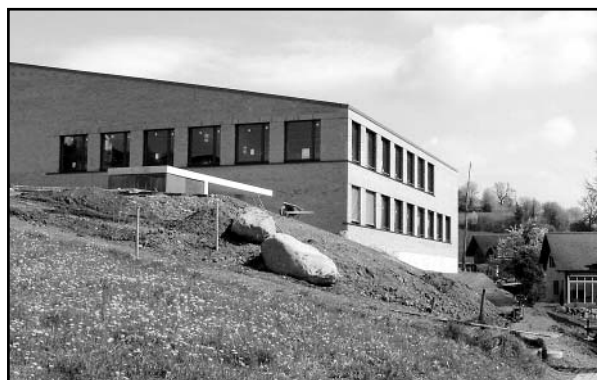
Umgebungsarbeiten und Erstellung der neuen Wegverbindung Festspielstrasse-Sims-gasse.
