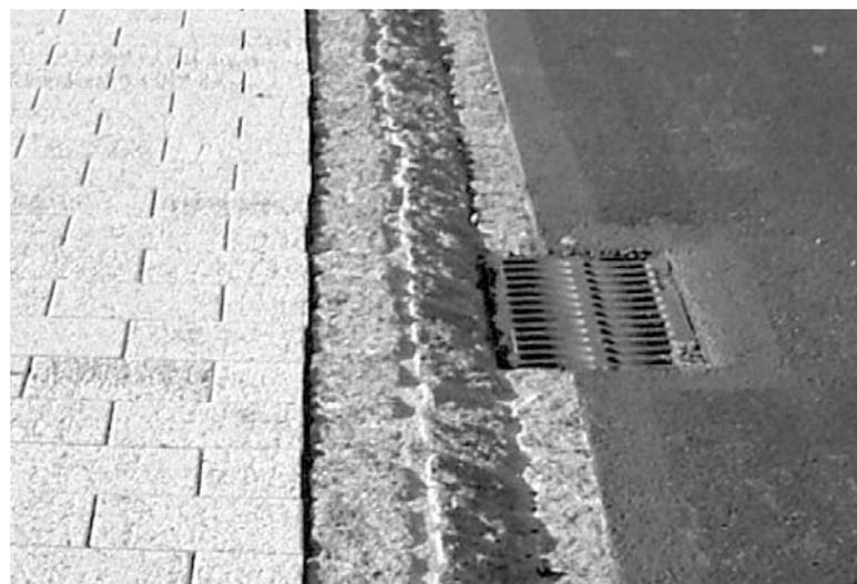
**Der Übergang von Trottoir zur Strasse:** Die Ausführung des Trottoirs erfolgt in Betonverbundsteinen mit gestürztem Randstein.
