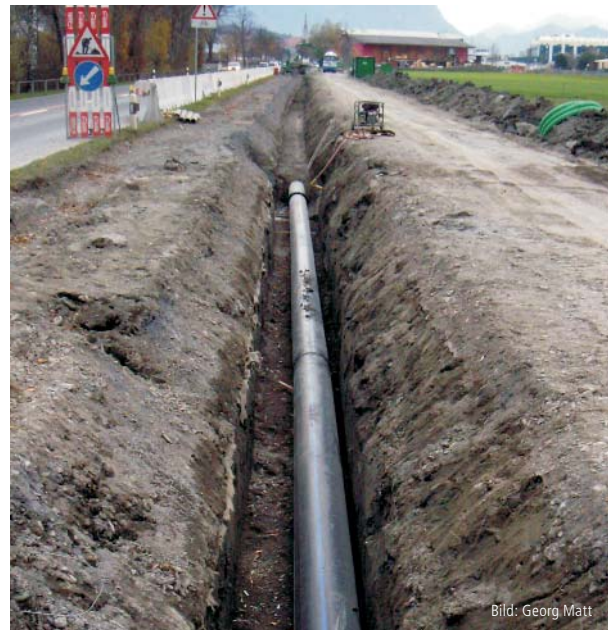
Neue Wasserleitung: Im Jahre 2008 musste infolge des Neubaues der Dampfleitung auch die bestehende Wasserleitung durch eine neue ersetzt werden. Im Bild die sauber verlegte, neue Wasserleitung neben der Schaanerstrasse.
