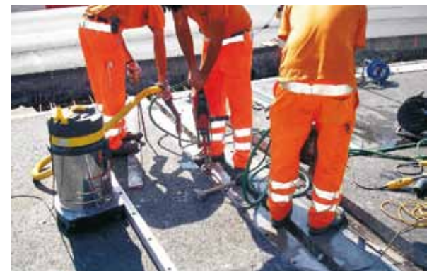
Fahrbahn-Trennfugen.
