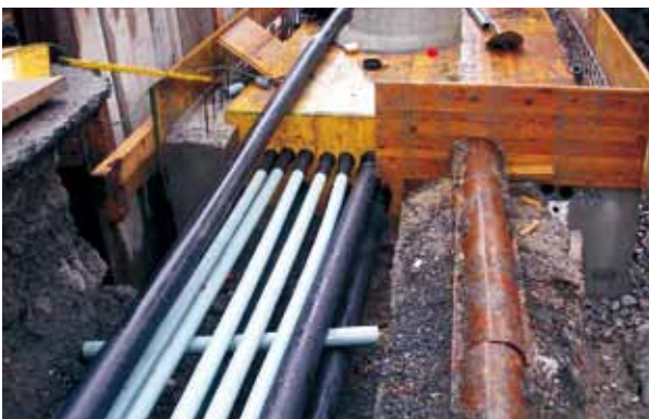
Einbau diverser Werkleitungen.
