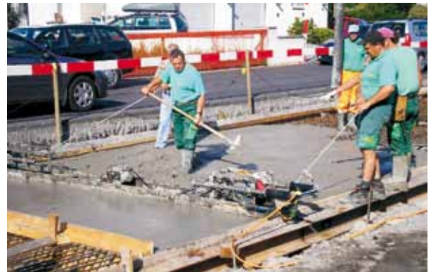
Betonieren der Fahrbahnplatte.
