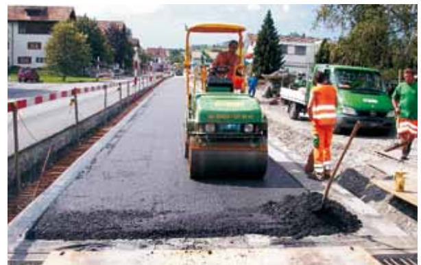
Asphaltschicht als Schutzbelag.
