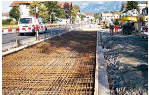
Armierung Fahrbahnplatte.
