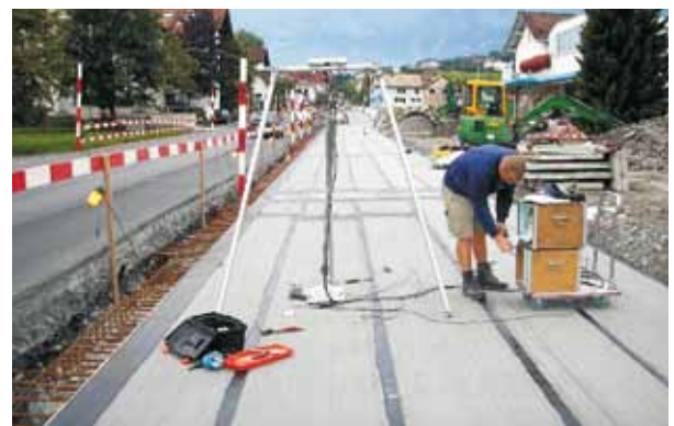
Kontrolle der Abdichtung.
