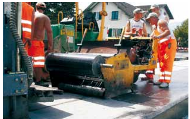
Abdichtung der Fahrbahnplatte.
