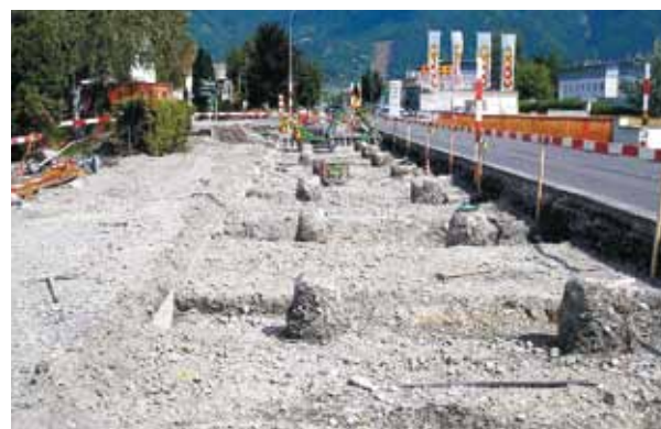
Pfahlköpfe als Strassenauflage.
