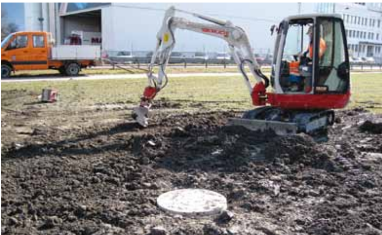
Einbau Sammelschacht: Neben dem ARA-Hauptsammelkanal mussten zwei Schächte wieder erstellt werden.
