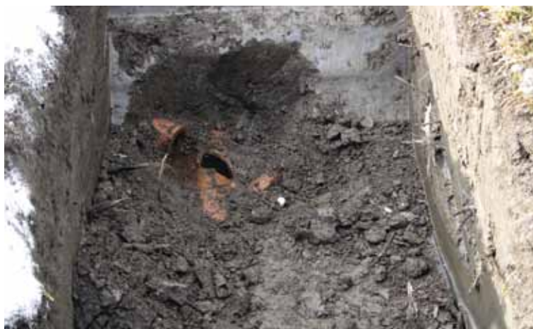
Tonrohrsystem Kanal bis zur Landstrasse: Ist in sehr gutem Zustand (Baujahr 1967).
