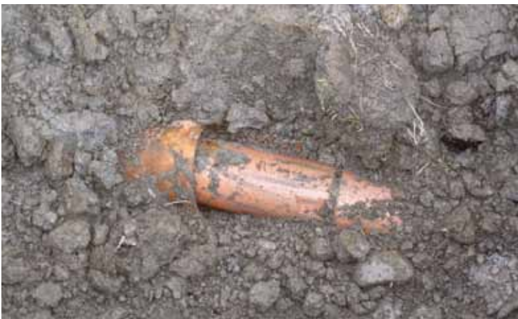
Verbindung alt-neu: Anschluss Tonrohrleitung an eine neue Drainagesammelleitung PVC 150.
