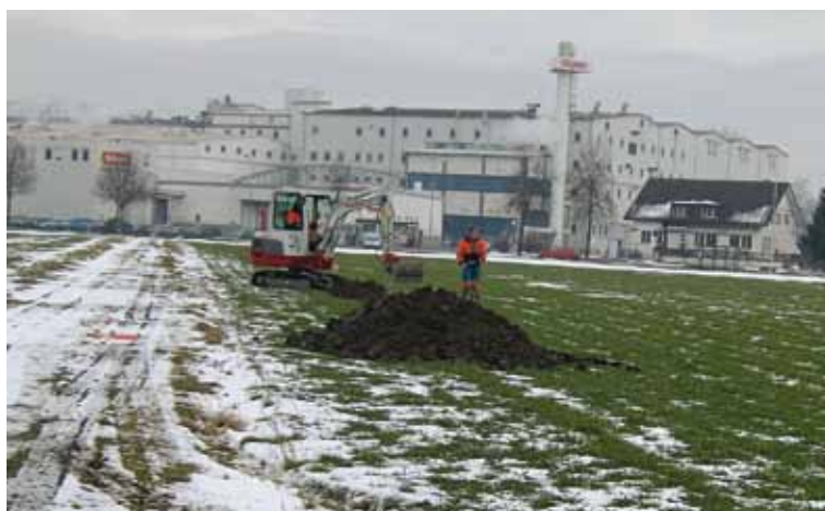
Ausheben der Saugerleitungsanschlüsse.
