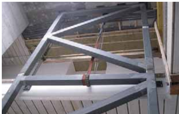
Dritte Etappe: Einbauarbeiten der Stahlkonstruktion.
