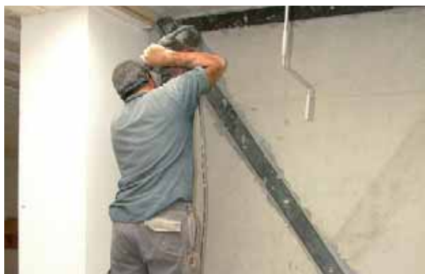
Erste Etappe: Stahllamellenmontage.
