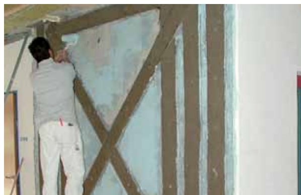
Erste Etappe: Verputzarbeiten.
