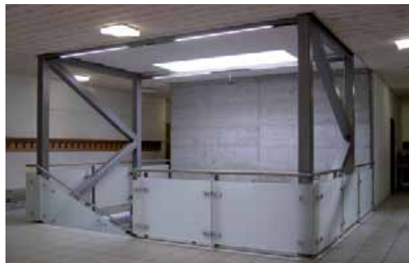
Dritte Etappe: Fertiggestellte Stahl- und Schlosserarbeiten.
