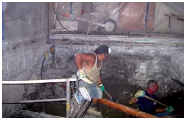
Zweite Etappe: Abbrucharbeiten und Handaushub.
