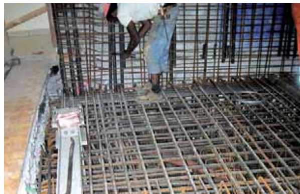
Zweite Etappe: Stahleinbauten und Armierungsarbeiten.
