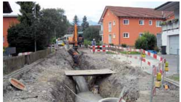
Abschnitt 2: Storchenbühl bis Strassenende. Baubeginn August 2010.
