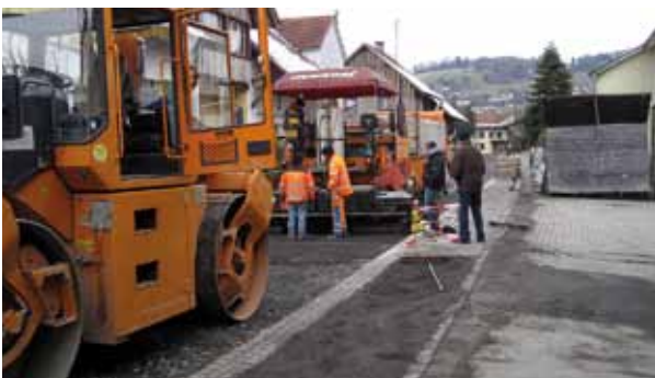
Abschnitt 1: Einbau Feinplanie Ende November 2010.
