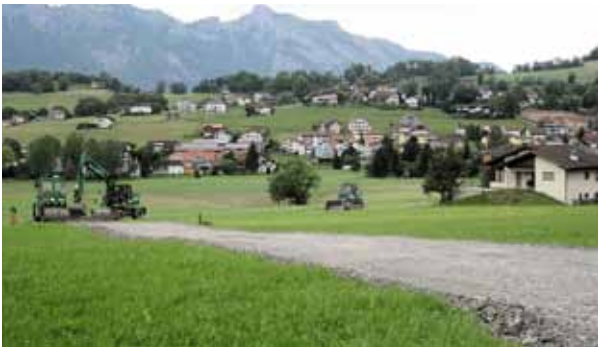
Bau der Umfahrungsstrasse: Juni 2010.
