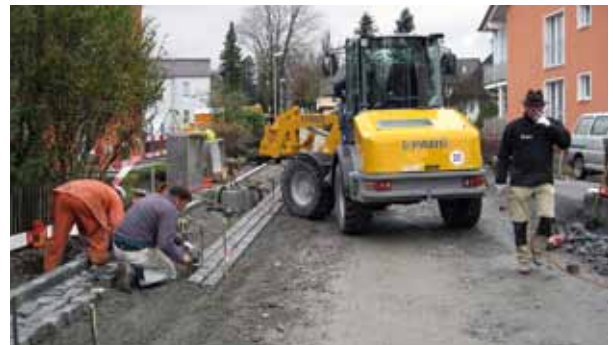
Abschnitt 2: Pflasterarbeiten November 2010
