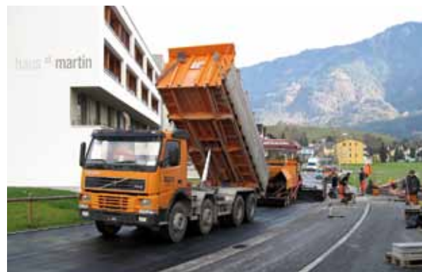
Einbau des Deckbelags an der Dr. Albert Schädler-Strasse.
