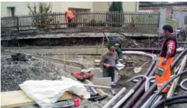
Abschnitt 1: Kabelschutzrohre für Strom und Kommunikation werden verlegt (September 2010).
