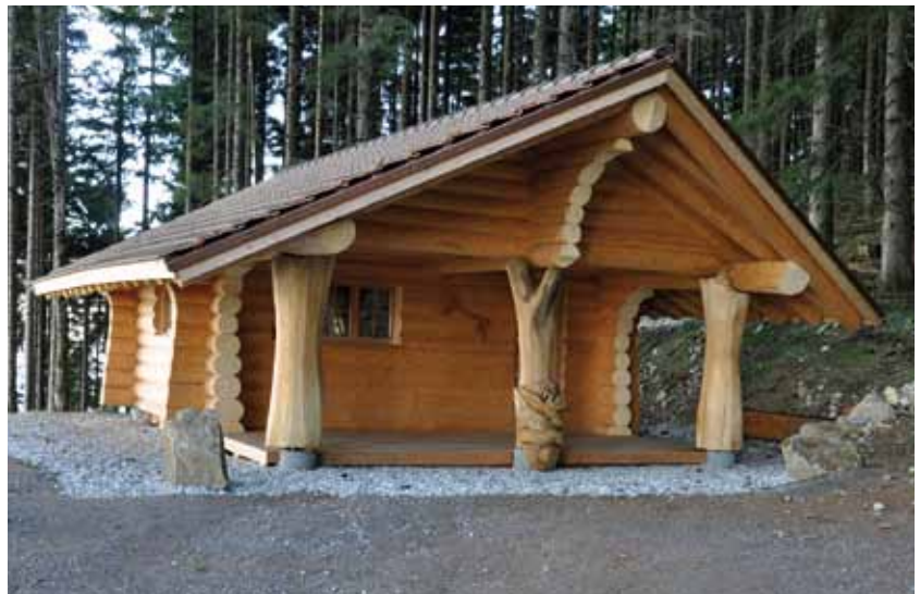
Uli Mariss Hütte: In 1153 Frondienststunden wurde die Hütte wieder aufgebaut.
