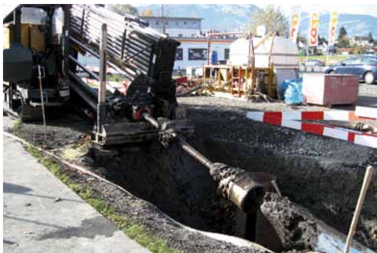
Horizontalbohrung: Die eingezogenen Wasserleitungen werden im Anfangsbereich abgesenkt und mit den bestehenden zusammengeschlossen.
