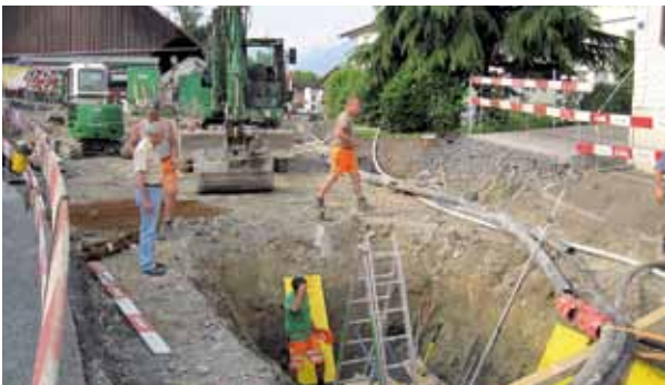
Abschnitt 1: Grossfeld–Storchenbühl. Baubeginn Juni 2010.
