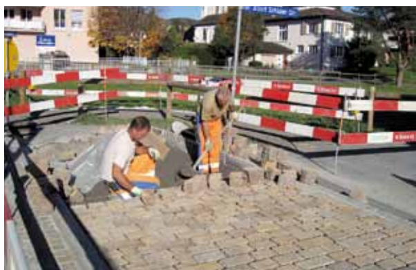
Trottoirpflasterung mit Porphyrsteinen als gut sichtbarer Fussgängerübergang.
