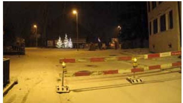
Abschnitt 1: Geplanter Belagseinbau musste wetterbedingt verschoben werden (Dezember 2010).
