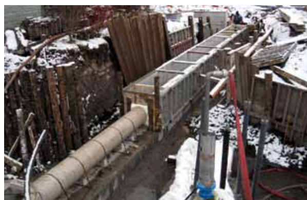
Kanalisationsanschluss in die BU Grosser Britschen.
