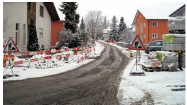
Abschnitt 2: Witterungsbedingter Bauunterbruch (Dez. 2010)
