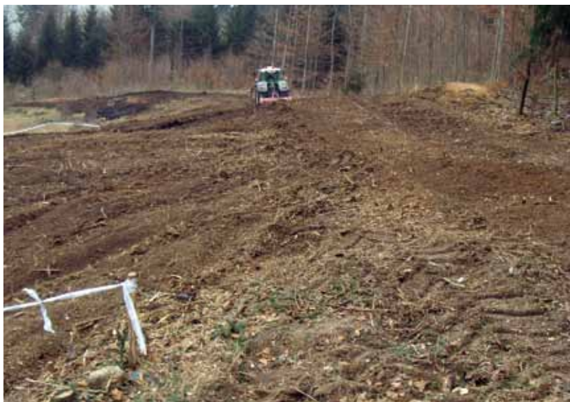
Erweiterung der Schutzzone S1: Im Jahre 2010 wurde bei den Moltaquellen im Schaanwald aufgrund neuer Erkenntnisse die Schutzzone S1 (Fassungsbereich) erweitert und die gesetzlich geforderte, naturbelassene Wiese erstellt. Im Bild eine Baumaschine beim Ausführen der Mulcharbeiten.
