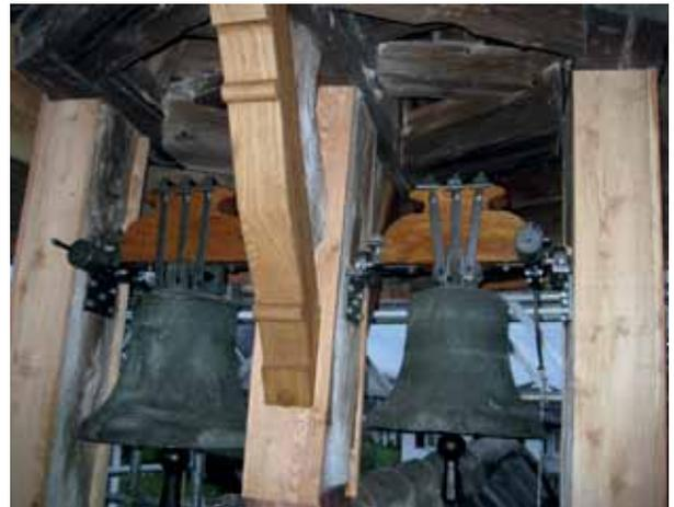
Glockenanlage mit neuen Eichenjochen, Glockenklöppel und Zuggestänge. Im Vordergrund die Helmdachstabilisierung.
