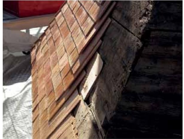
Neue Lärchenglattschindeldeckung mit Schwenkgrad und wechselseitigem Überstand.
