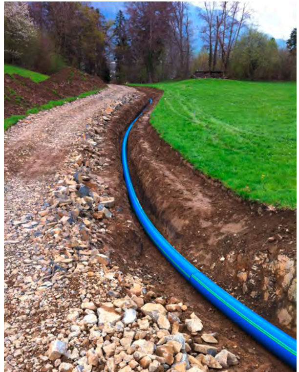
Wasserleitung im Bereich Studa oberhalb von Ruggell.
