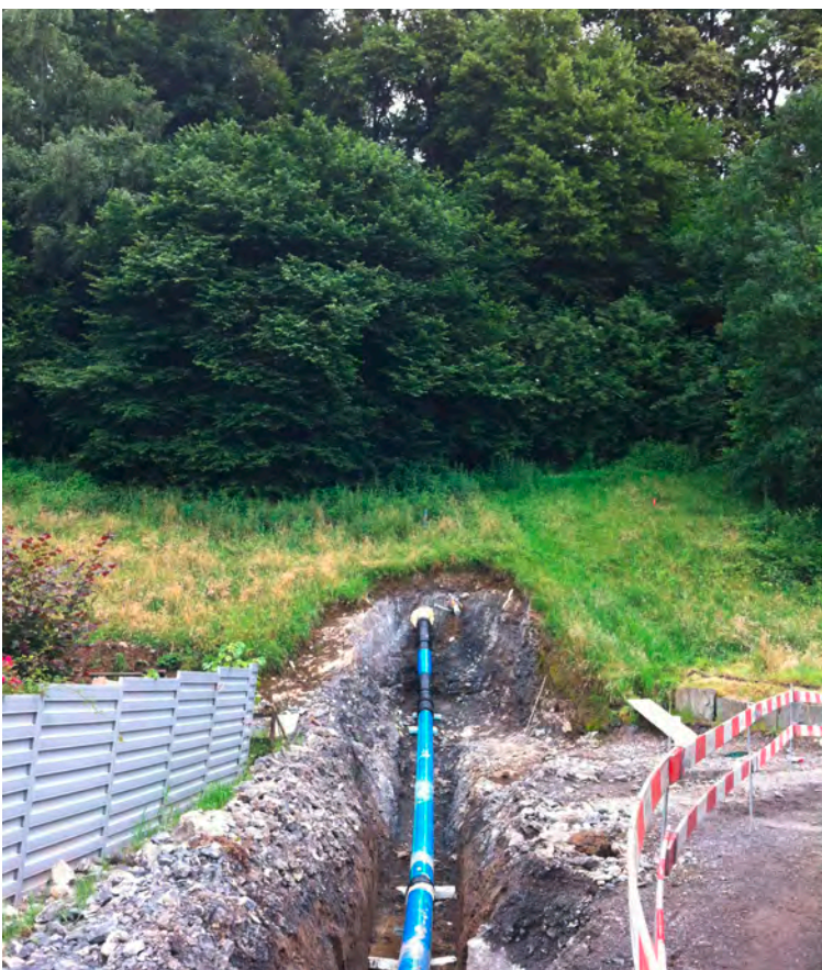
Einführung der Wasserleitung in die Kernbohrung, welche unter dem Wald hindurchführt.
