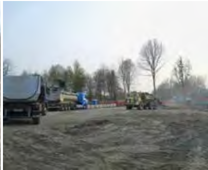
Sanierung in voller Aktion
