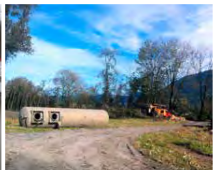
Rückbau Rückhaltetanks beim Triageplatz
