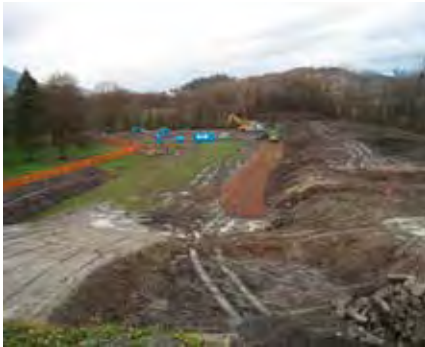
Übersicht Bau und Triageplatz
