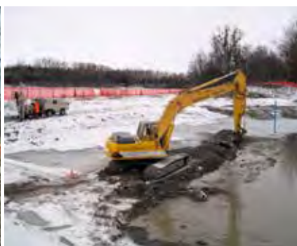
Baustrasse für MIP-Bohrungen
