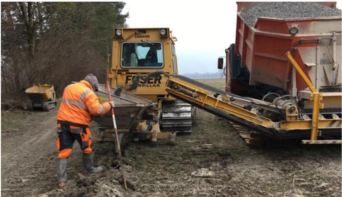
Abbildung: Erstellung der Sickerschlitze
