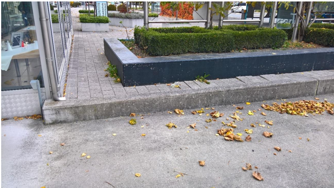
Abbildung 1: Trennmauer zwischen Eingang Mehrzweckgebäude und Vorplatz Feuerwehr
