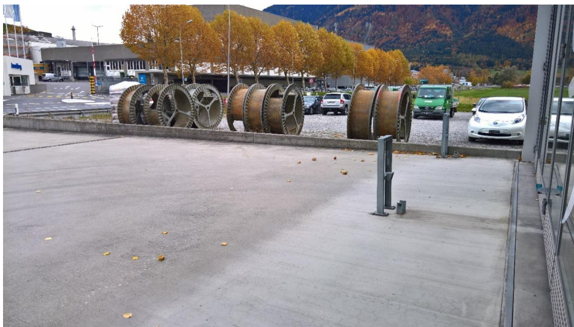
Abbildung 2: Trennmauer zwischen Kiesparkplatz und Vorplatz Feuerwehr
