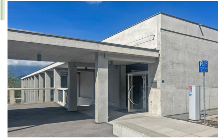
Aula Turnhalle Sebastianstrasse 54
