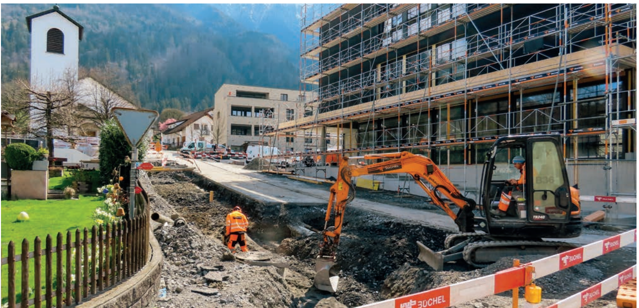
Erstellung der Trinkwasserleitungen
