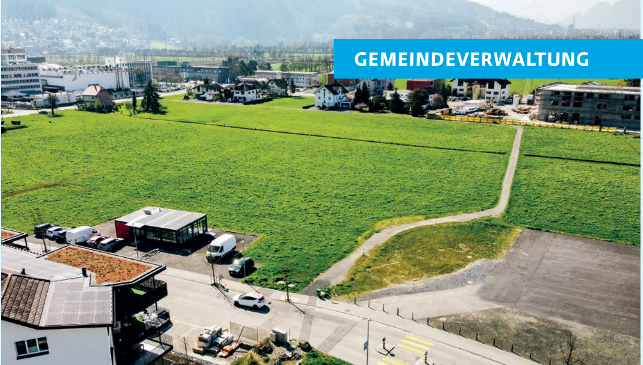
Gebiet «Gross Bretscha» mit dem bestehenden Fussweg Pfarrer Ludwig Jenal-Weg und der Baustelle Essanemarkt (Migros) im Hintergrund
