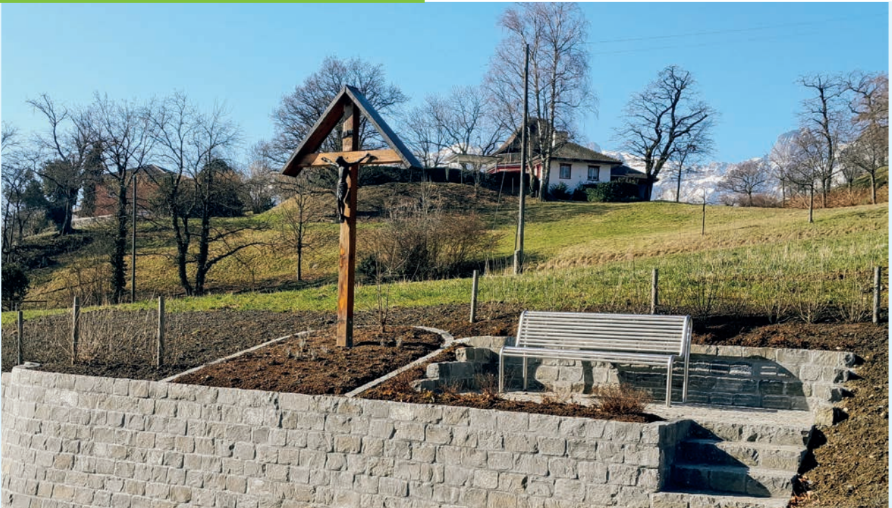
Die bestehende Anlage (kleines Bild) wurde einer umfassenden Neugestaltung unterzogen.
