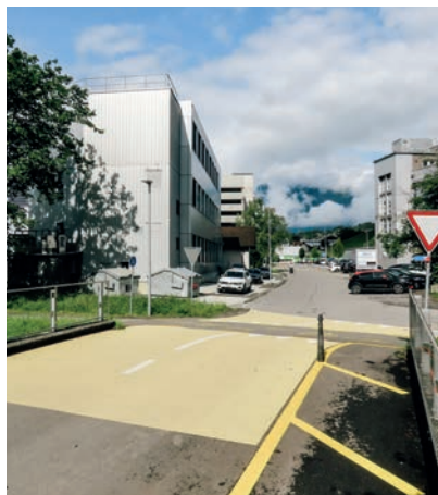
20 | Zufahrt Sportpark: neue Bodenmarkierung
