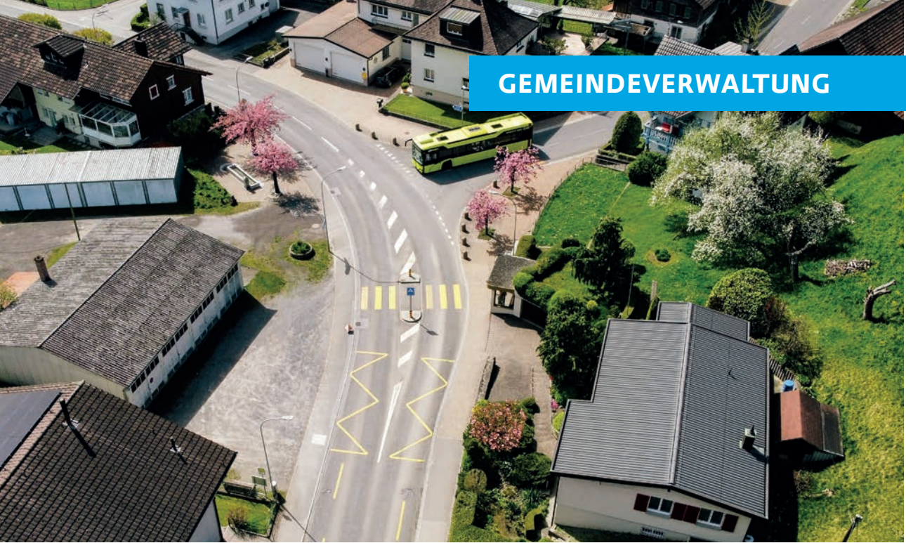
Luftaufnahme Strassenknoten Kohlplatz – Heragass
