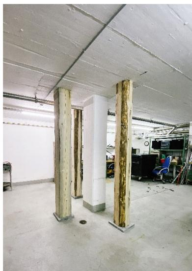
Abbildung 2: Um ein Durchstanzen des Saalbodens zu verhindern, wurden die vier Stützen mit Baumstämmen verstärkt.
