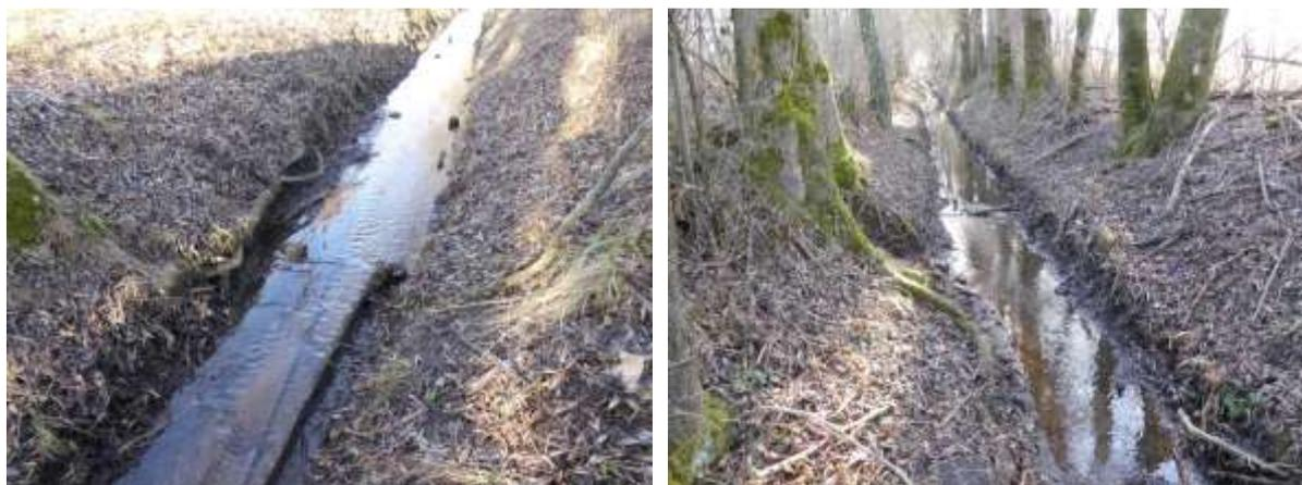
Abb. 12/13: Schlechter Zustand der Sohlbretter auf dem Grossteil des Grabenverlaufs (links). Bei beidseitigem Bewuchs des Grabens mit Bäumen beschränken sich die Massnahmen auf eine Abtiefung des Gewässergrunds (rechts).
