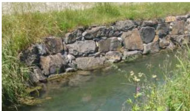
Abb. 29/30: Beispiel Buhne (links) Blocksteinmauer ohne Beton (rechts)
