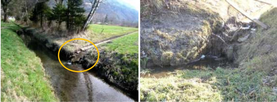
Abb. 7/8: Die Einmündung des Rietgrabens aus dem Jörlismad-Rossrietli in den Erlenbach weist eine für Kleintiere kaum überwindbare Stufung auf und ist anzupassen.
