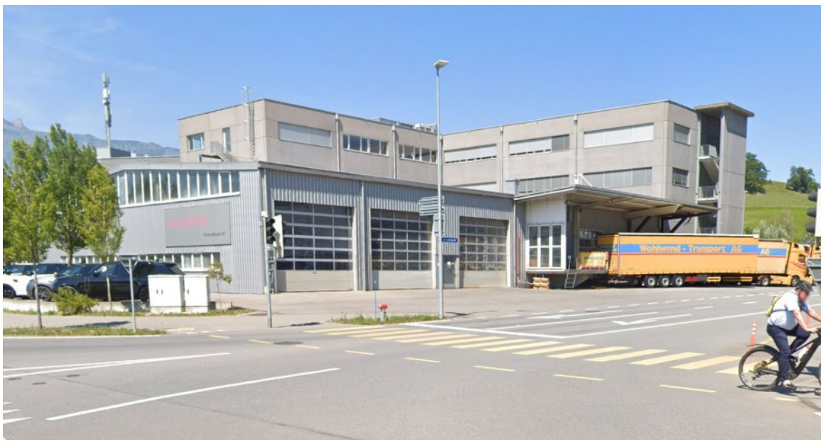
Abbildung 4: Situation vor Ort mit dem unternutzten Teil im vorderen Bereich
