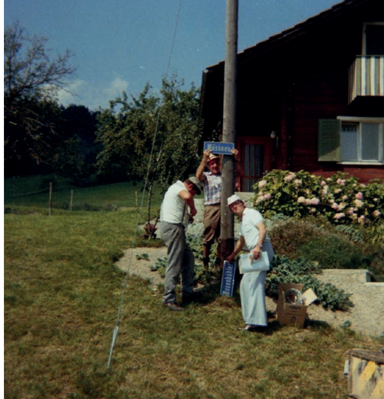
Legte als Gemeindebauführer selbst Hand an: Erich Allgäuer (rechts) zusammen mit Hugo Hoop und Hans Wanger bei der Montage der Strassennamensschilder in Eschen und Nendeln im Sommer 1978.
