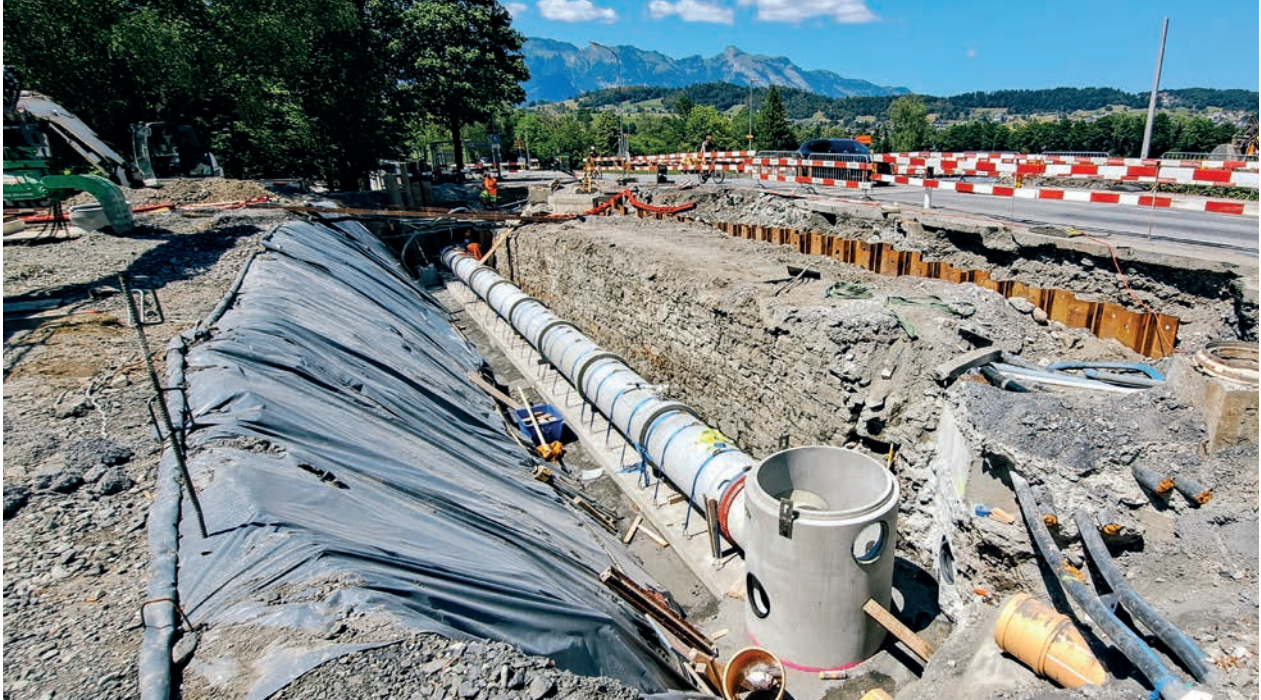
Werkleitungsarbeiten im Bereich Eisenbahnkreuzung Rheinstrasse.
