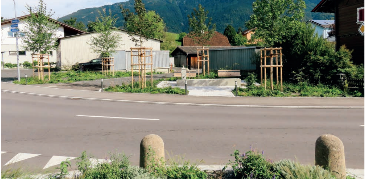
Erneuerter Strassenraum mit neuer Infrastruktur.
