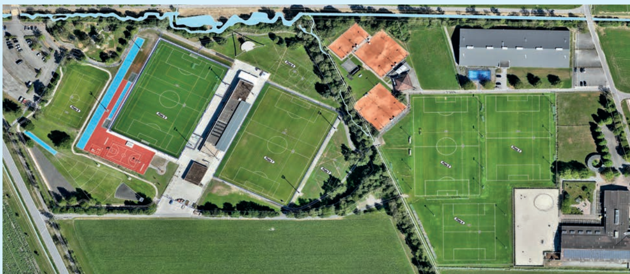
Übersicht Sportpark nach Sanierung
